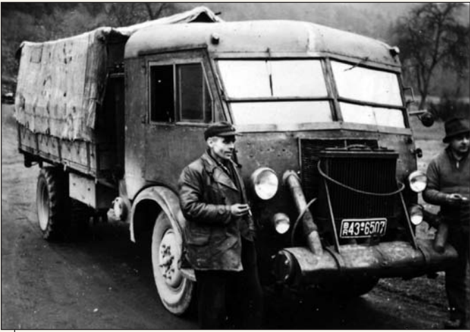
Bausatz - aus Teilen mehrerer LKW baute Erwin König diesen Pseudo-Panhard mit Maybach-Motor und setzte ihn gemeinsam mit seinem Bruder Ernst ein.
